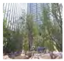
植栽工事中の大手町の森
